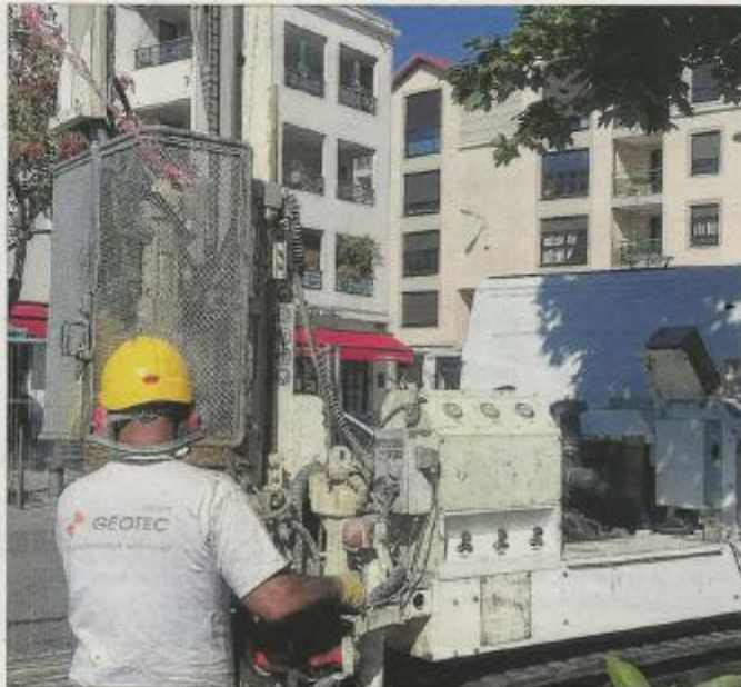
Des sondages sont actuellement réalisés dans le cadre des investigations géologiques et géotechniques menées pour le projet de Ligne E, dans le secteur de Tassin. Photo DR/Géotec
